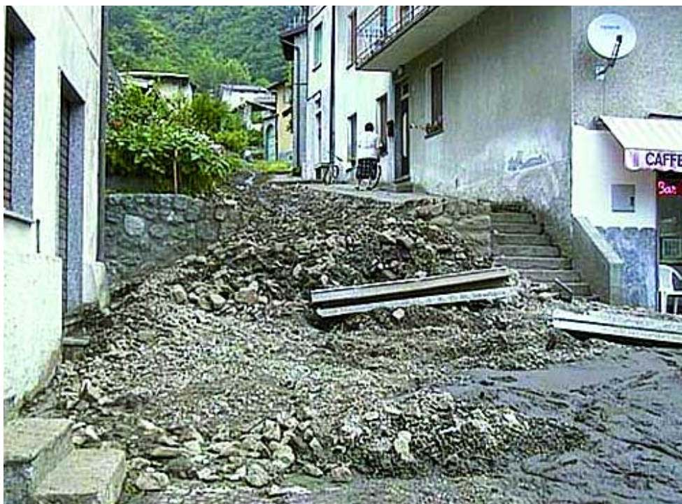
Scivolamento a valle di terreno e detriti.
