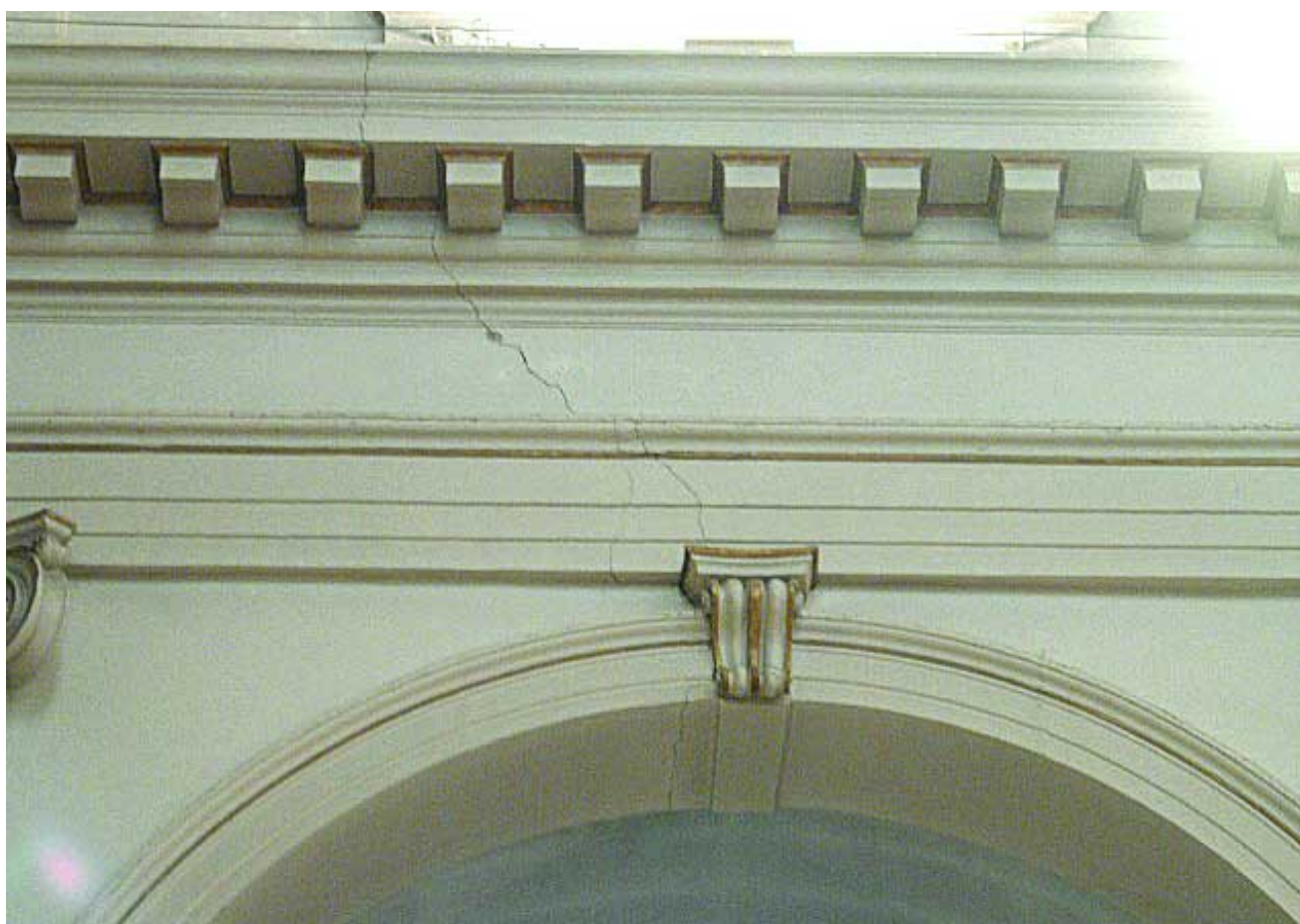
Arco costituito da muratura stratificata che tende a scollegarsi sotto carico, con rischio di crollo locale.
